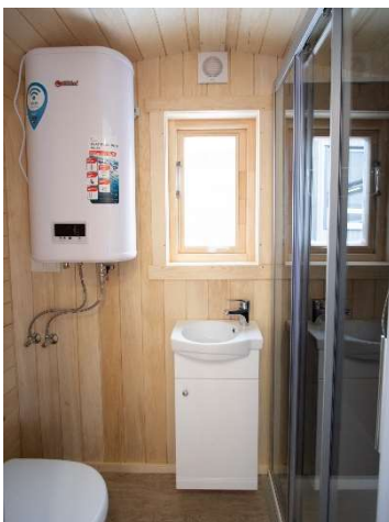
Fertig installierte Sanitäranlagen mit Warmwasserspeicher, Hausanschlüsse bereits vorbereitet
